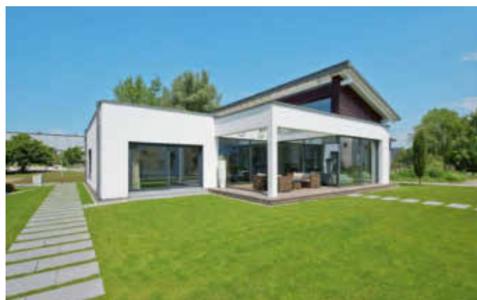
Komfortabel wohnen - auch im Alter. Mit der richtigen Planung ist das problemlos möglich. Foto: djd/WeberHaus.de
