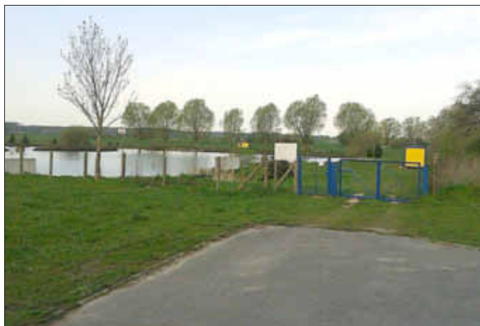
Blick durch das reparierte Eingangstor auf das Gewässer
