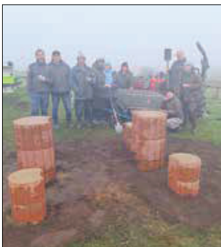
Erstes Ziel erreicht: Das Fundament für die Bänke wurde errichtet
