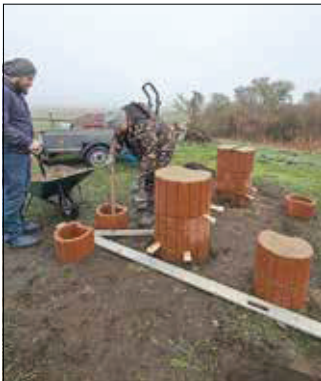
Mit Sorgfalt werden die Pflanzsteine platziert und mit Beton gefüllt.
